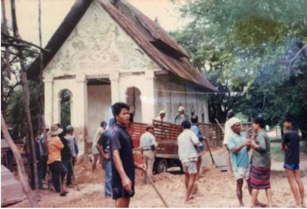
อุโบสถหลังเก่า กว้าง ๕ เมตร ยาว ๘ เมตรเป็นอาคารคอนกรีต ได้รับพระราชทาน วิสุงคามสีมา เมื่อ พ.ศ. ๒๔๘๐
